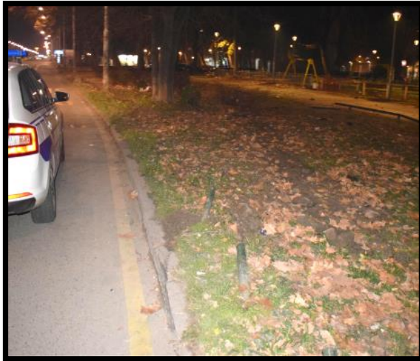
Sl. 3 - Trag levog točka prilikom prelaska preko ivičnjaka i polomljen stub saobraćajnog znaka i u smeru kretanja BMW iskrivljeni metalni stubići
