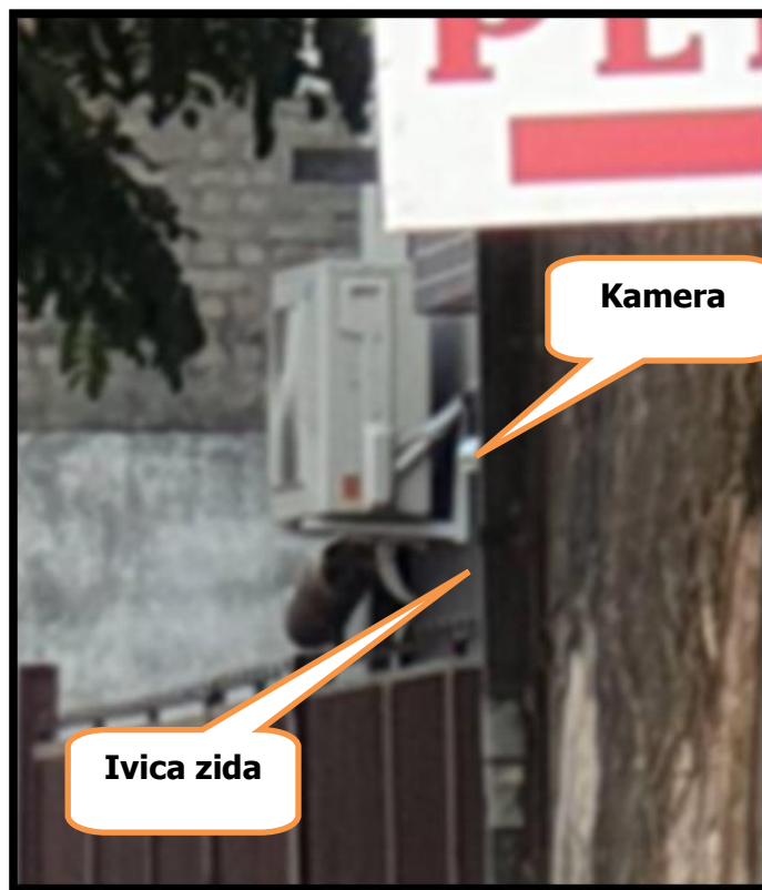
Slika 4 - Kamera i ivica zida
